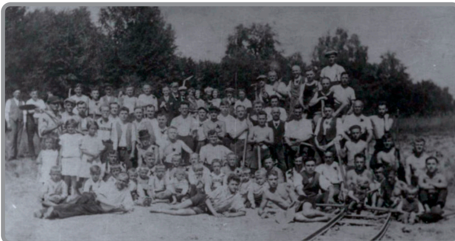
Bauarbeiten am neuen Standort der Sportbaracke
