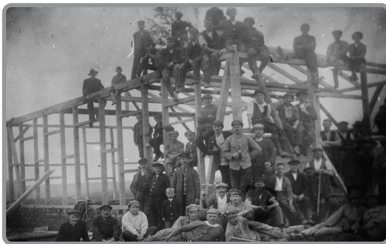
Bauarbeiten an der ersten Turnhalle in Bräunsdorf
